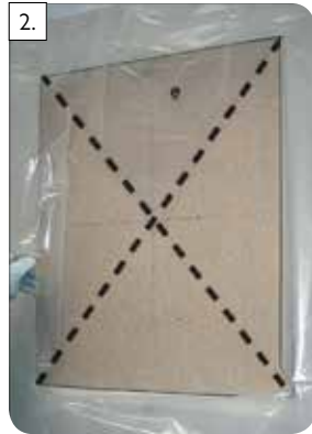
2. Parotesnú bariéru prerežte priečne na požadovanú veľkosť otvoru (pozri obrázky).
