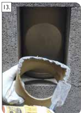
Po vyčistení styčných plôch naneste tmel na dodatočné napojenie dymovodu.
