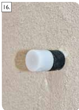
16. Pohľad na hotové vyústenie meracej trubice.
