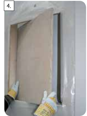
4. Odstráňte panely na báze dreva, tepelnú izoláciu atď. z montážneho otvoru.
