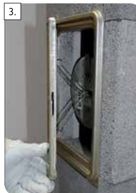
3. Dvierka uzavrite, rozperné prvky dotlačia uzáver v dvierkovom kuse.
