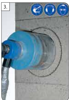
3. Pre vnútorný otvor s menšou vrtacou korunou prevrtajte opatrne tvárnicu a šamotovú rúru.
