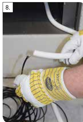
Dátový vodič prepojte v ochrannom vedení s elektrorozvádzačom.
