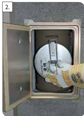
2. Uzáver pre komínový prieduch odvádzajúci spaliny od spotrebiča na tuhé palivá.
