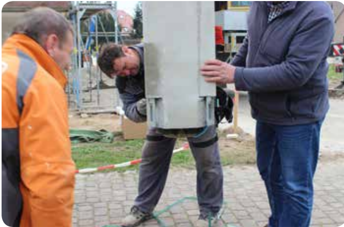
Montáž prefabrikovaných komínov s pevnými spojmi prvkov
