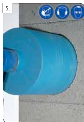
5. Otvor v tvárnici teraz vyrežte veľkou vrtacou korunou.
