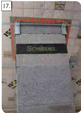
Pohľad na zaizolovaný prechod komína strešnou rovinou
