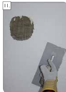
11. Úprava štruktúry omietky a pohľad na zrealizovaný prechod z exteriérovej strany.
