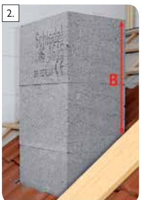
Zmerajte dĺžku strany komína B (krátku stranu) nad hotovou strešnou krytinou.
