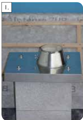
1. Pohľad pred začiatkom montáže
