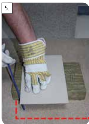
Zrežte odmeranú časť z čelnej dosky a priložte k hornej časti, tak aby ste vyplnili celý vyrezaný otvor v tvárnici.
