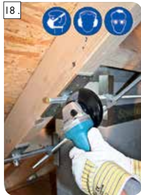
V prípade potreby skráťte prečnievajúce tyče.
