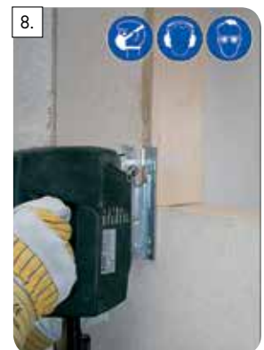
8. Otvory, ak je to potrebné upravte. Úplne obnovte tepelnú izoláciu okolo montážneho otvoru v ráme nosníka.
