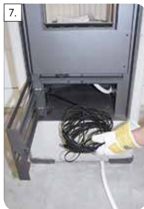
Vodič pre napojenie LUC zariadenia sa nachádza v spodnej časti tepelného spotrebiča. Vedenia má dĺžku 15 m pre bezproblémové napojenie dotykovej ovládania.
