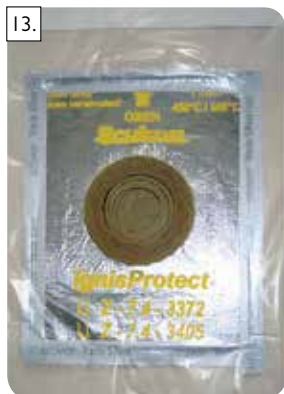
13. Pohľad na okolitú pevne pospájanú parozábranu na prvku IGNIS Protect.
