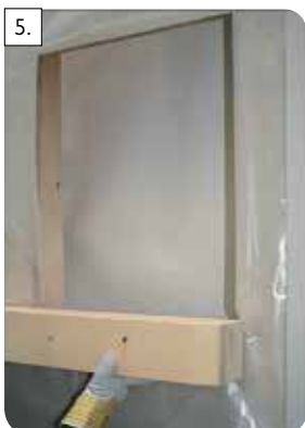
5. Zabudujte nosnú podporu pre prechod IGNIS Protect. Nainštalujte PROTECT do dreveného stánku.
