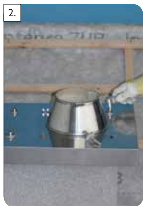
2. Odskrutkujte pripevňovacie skrutky krycej dosky
