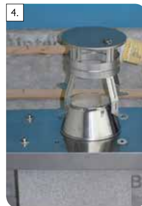
4. Silikónové tesnenia položte na dosku a následne umiestnite kryciu striešku na kryciu dosku tak, aby ste ju mohli uchytiť skrutkami.
