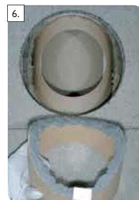
6. Po vyčistení styčných plôch naneste tmel na dodatočné napojenie dymovodu.
