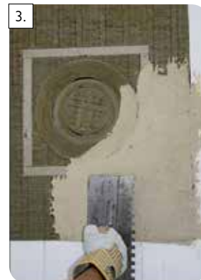
3. Naneste podkladovú omietku na vonkajšiu stranu IGNIS-PROTECT.
