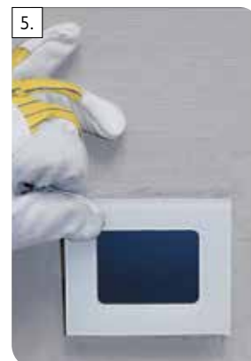
5. LUC-jednotku vložte a zafixujte v montážnej krabici.
