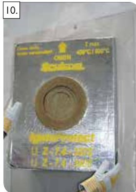
10. Precízne nainštalujte IGNIS-PROTECT. Hliníkovou fóliou potiahnutá strana má byť v interiéri!
