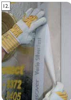
12. Parozábranu obvodovej steny a hliníkovú fóliu na IGNIS Protect prvku spojte páskou na to určenou.
