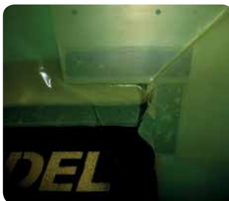
Detail rohového spoja fólii.
