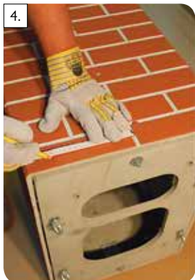
Určený rozmer C komínovej tvárnice naneste osovo na prefabrikovaný plášť.
