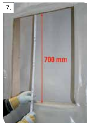
7. Skontrolujte veľkosť otvoru - výška 700 mm.
