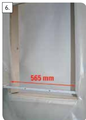
6. Skontrolujte veľkosť otvoru - šírka 565 mm.
