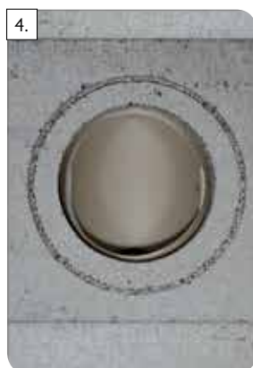
4. Pohľad na prevrtanú tvárnicu a vyvrtaný otvor v šamotovej rúre.
