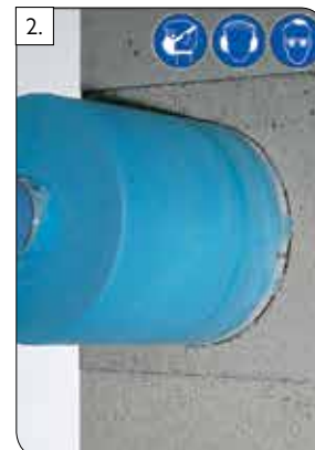
2. Do tvárnice si predvrtajte otvor do hĺbky cca. 10 mm pre neskoršie vyvrtanie otvoru veľkou vrtacou korunou.
