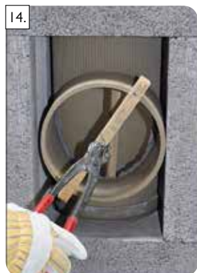
Po nalepení dodatočného napojenia ho zabezpečte proti pohybu.
