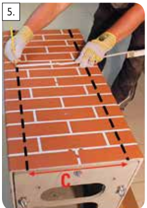
Určený rozmer C komínovej tvárnice naneste osovo na prefabrikovaný plášť.
