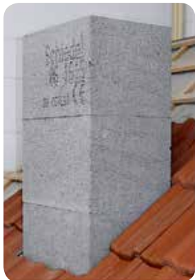
Pohľad na komín pred začiatkom montáže
