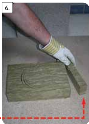
Zrežte odmeranú časť z čelnej dosky a priložte k hornej časti, tak aby ste vyplnili celý vyrezaný otvor v tvárnici.
