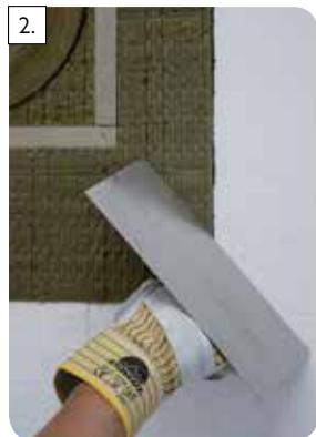
2. Skontrolujte presnosť osadenia prvku v stenovej konštrukcii
